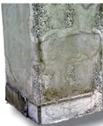
Con vibrador de alta frecuencia en barras de acero hacinadas
